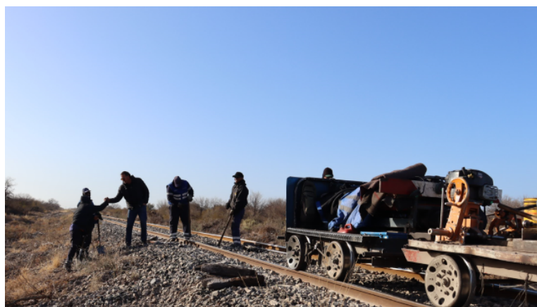
Cuadrilla del tramo La Paz-Mosmota. Foto Juan Sánchez, 2023.
