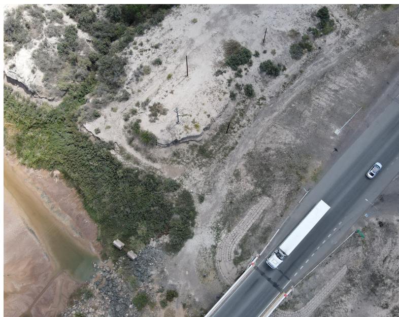
Vista aérea del puente carretero sobre el río Desaguadero, 2023.
